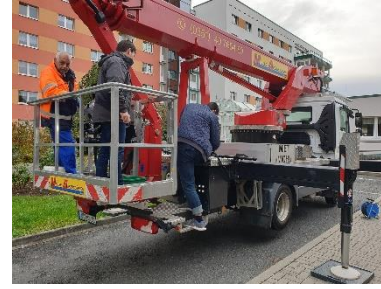
Hausmeister Claus Schröter lässt sich zum Baumschmücken mit der Hebebühne an die Spitze bringen. Bildrechte: MDR/Inna Buckup
